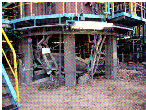
Figure 4 : Vue des dégâts sur la partie supérieure du surchauffeur et de l'effondrement de la sole (DREAL Lorraine)
