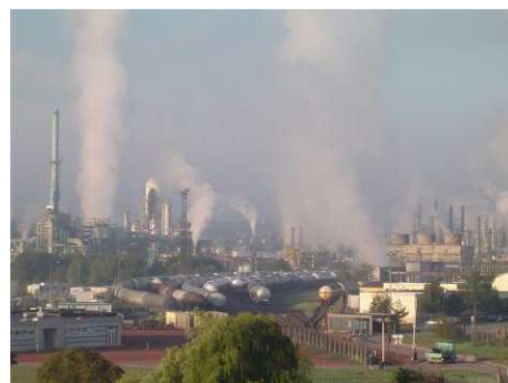
Figure 1 : Vue extérieure du site (DR)
