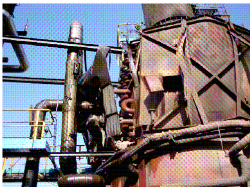
Figure 4 : Vue des dégâts sur la partie supérieure du surchauffeur et de l'effondrement de la sole (DREAL Lorraine)
