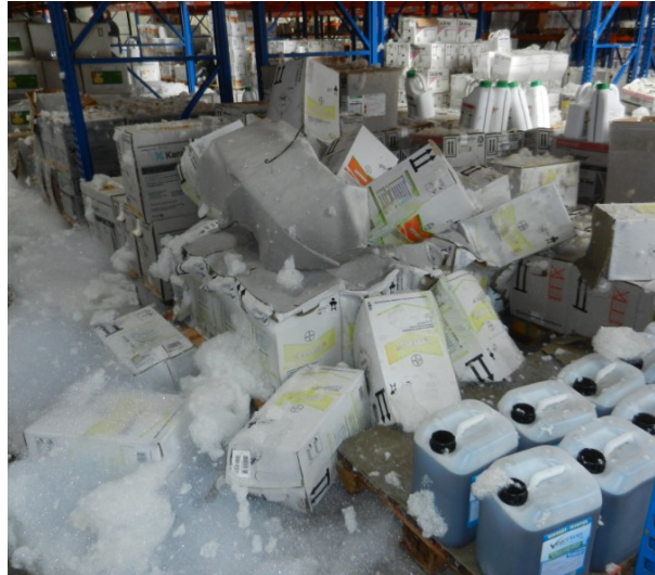
Figure 3 : État de la cellule 1 après le déclenchement de l'extinction mousse (Source exploitant - DR)
