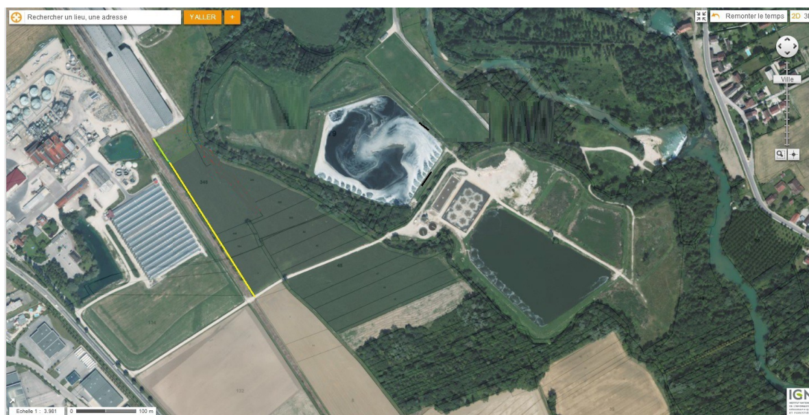
Représentation (en jaune) de la digue construite durant cet épisode de crue (DR exploitant)
