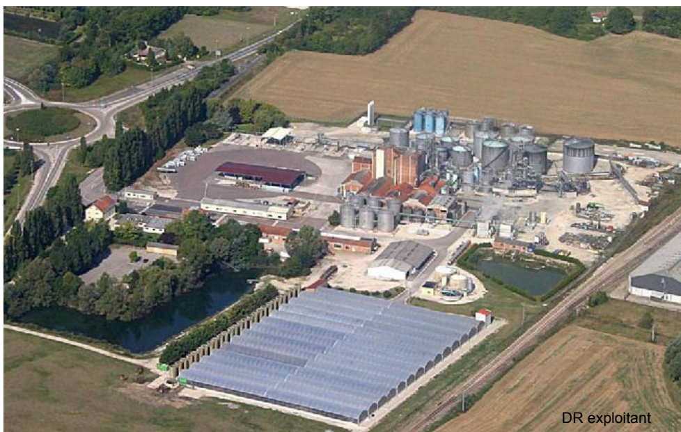
Usine chimique spécialisée dans la production d'alcool et le recyclage de solvants, située à Buchères (Aube)
