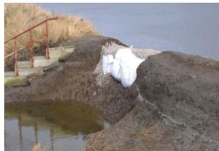
Schéma 3. Rupture de la digue de protection, avec dispositif d'étanchéité provisoire.
