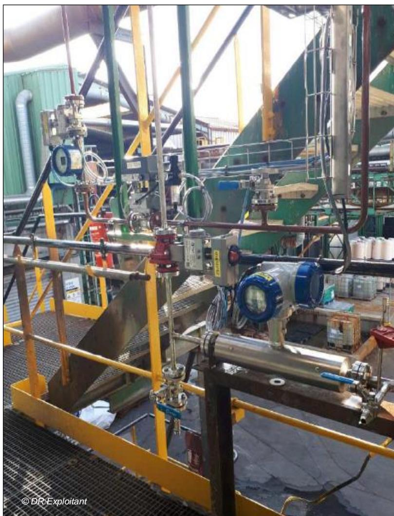
L'exploitant apporte également des modifications techniques à son installation. Il éloigne les ensembles tuyauteries – vannes – débitmètre des combustibles liquides de la façade de la post-combustion.
